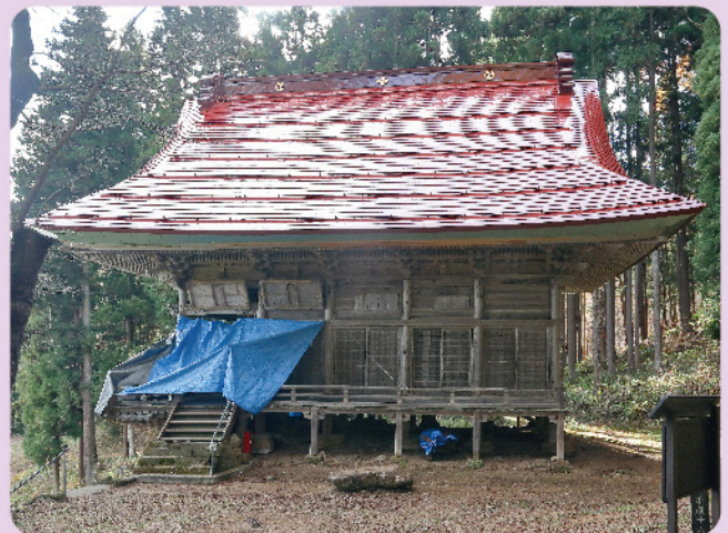
葺替工事が終わり輝きを取り戻した観音堂
